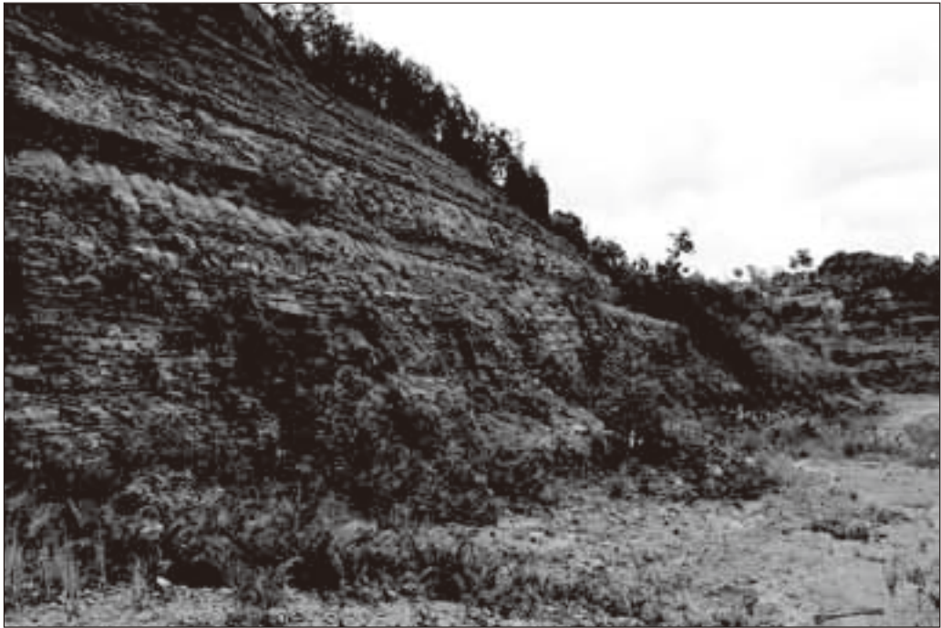
圖 6-4：南部露天礦邊坡照片
