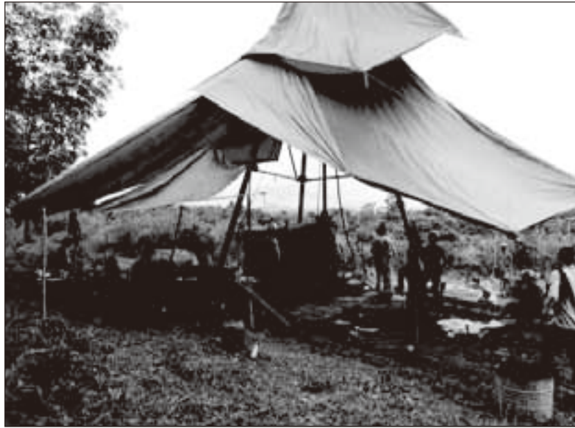
圖 7-1：ZK104 鑽探現場
